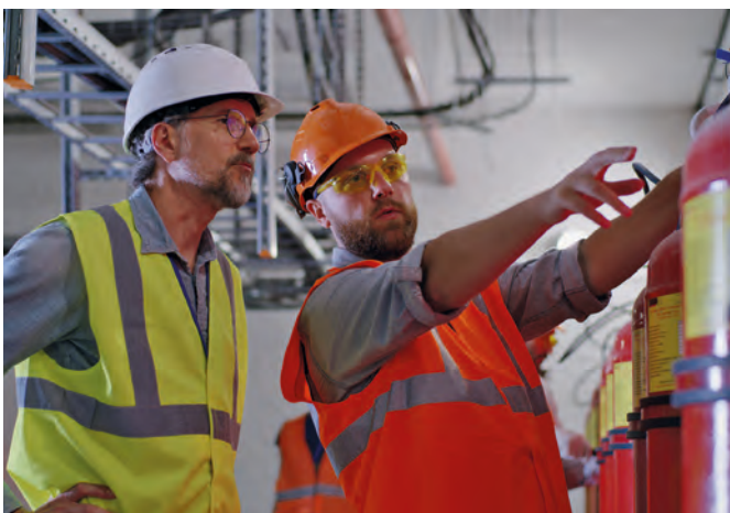
Feuerlöscher müssen spätestens alle 5 Jahre einer intensiven Prüfung unterzogen werden.
